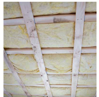
Die Zwischenräume einer Decke lassen sich am besten mit mineralischen Dämmstoffen ausfüllen.
